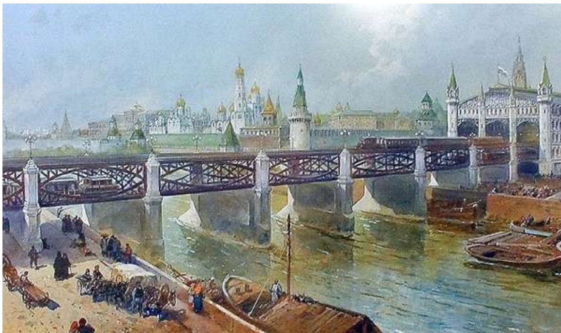
Рис. 12. Эстакада и Центральный вокзал метрополитена. Москворецкий мост
