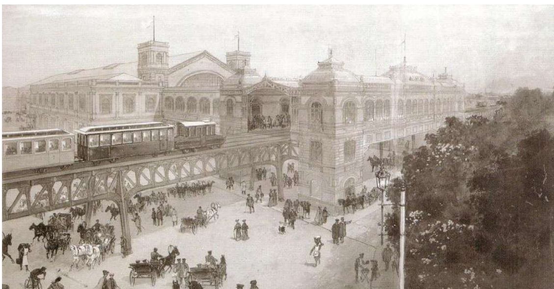
Рис. 9. Станция скоростной дороги у Балтийского вокзала
